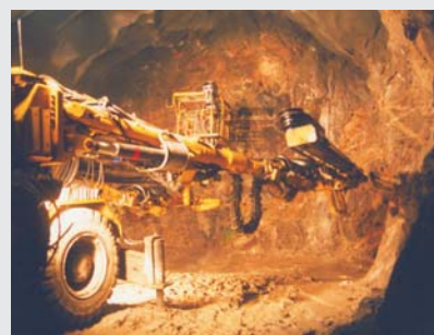
Leirinfisert berg i Frøyatunnelen
